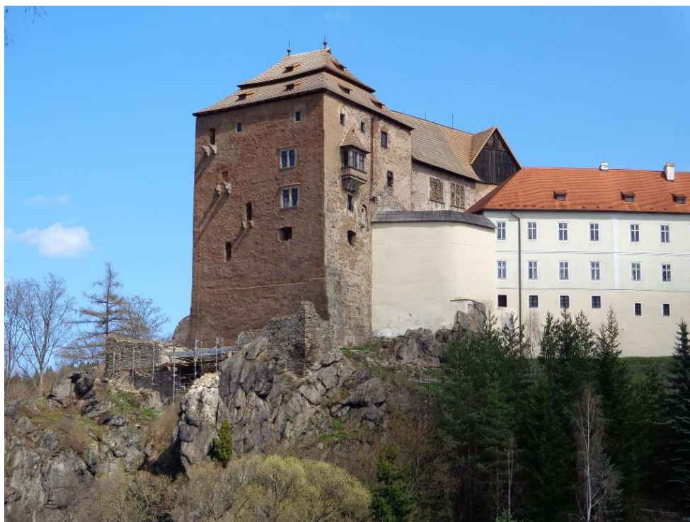
Hrad Bečov, probíhající rekonstrukce parkánových hradeb a obnova mostu
